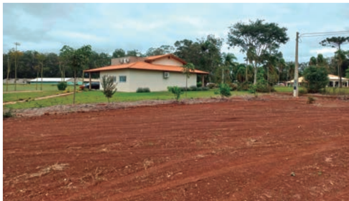
Terraplanagem na sede Lagoa do Sino
