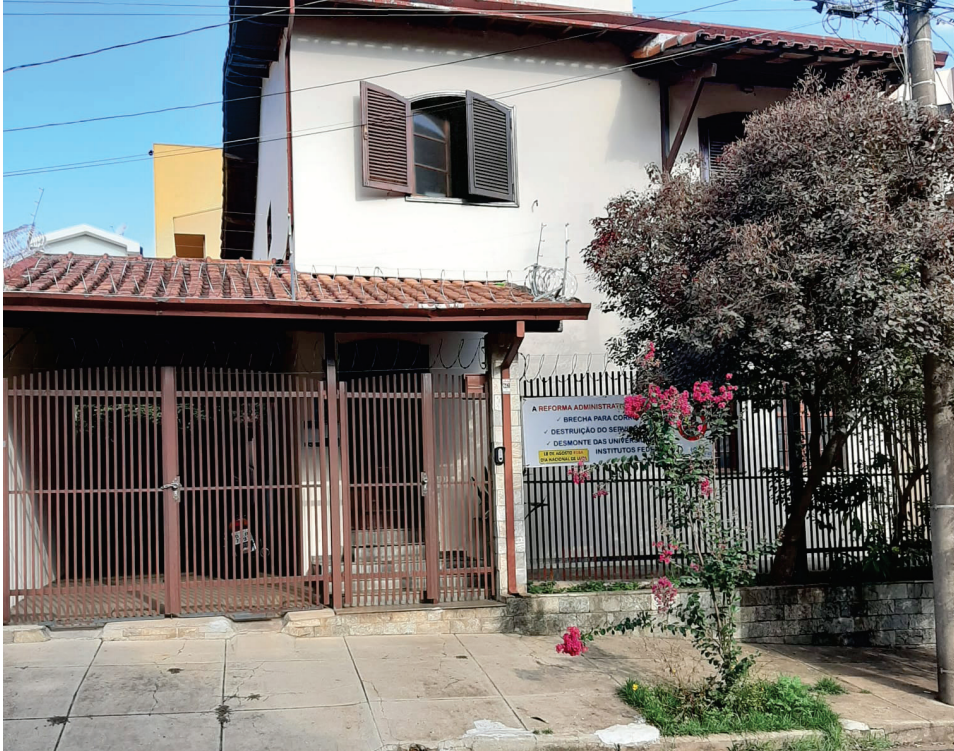
A Sede administrativa está funcionando na Rua Wadi Cury, 80 – Parque Arnold Schimdt
